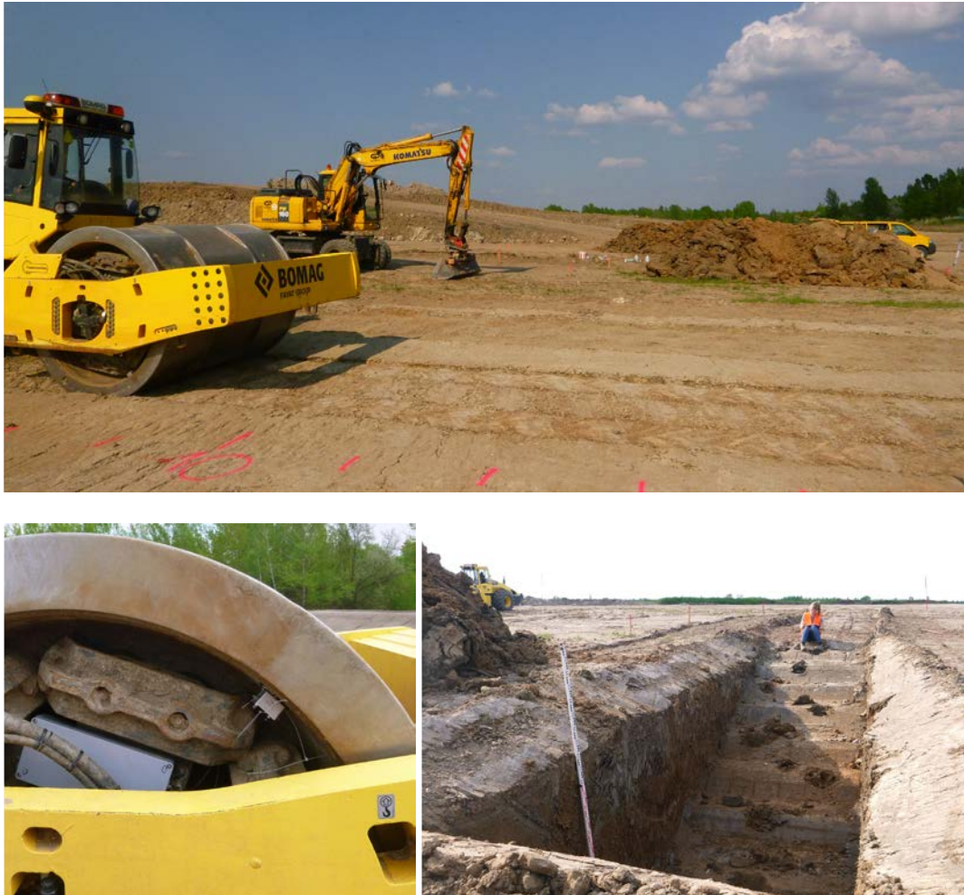
Abbildung 17. Messspuren am Versuchsfeld nahe Leipzig (Bild oben), Messtechnik (Sensoren, Spannungsversorgung, Datenlogger) (Bild unten links) und lagenweises Aufgraben eines Messbereich (Bild unten rechts)
