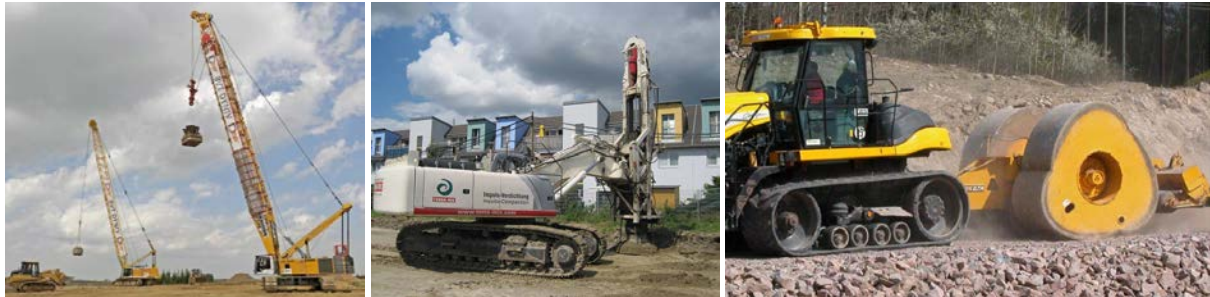
Abbildung 9. Dynamische Intensivverdichtung, www.dyniv.de (2014, linkes Bild), Impuls-Verdichtung, www.terra-mix.com (2014, mittleres Bild), 3-Seiten 25 kJ Impact Roller, www.landpac.com (2014, rechtes Bild)
